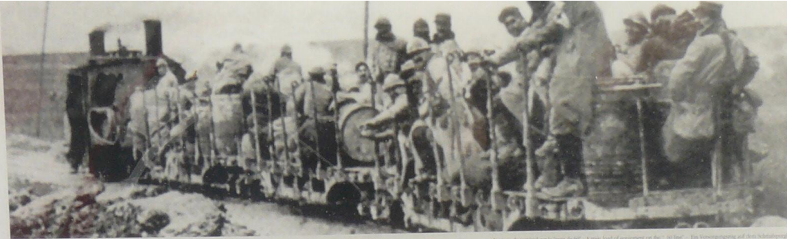
Le train de matériel sur la "voie de fer" - A train load of equipment on the "rail line" - Ein Vorwärtsgang auf dem Schienenwegen
